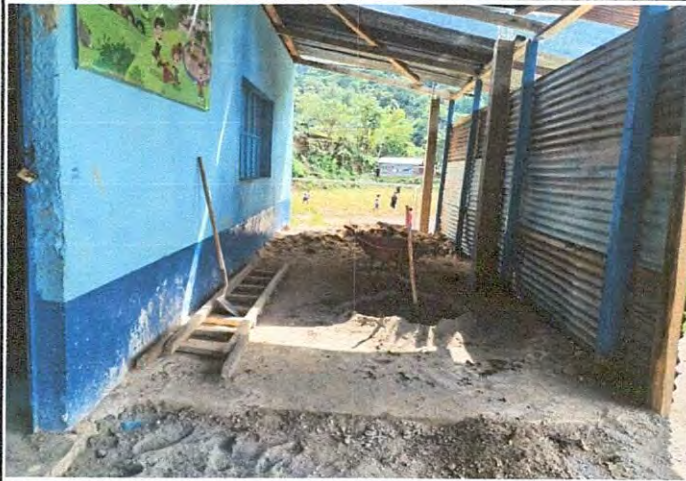
Foto1: Reparación de losa de patio
