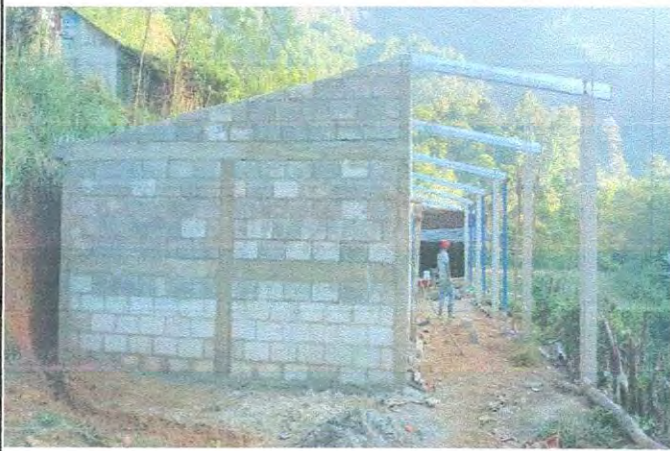
Foto 1: Mejoramiento al módulo de aula (estructura de techo con lámina troquelada calibre 26, piso cerámico, balcones, repación de repello y cernido de paredes)
