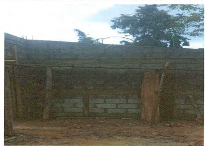
Foto 2: Remodelación de aula tipo portico
