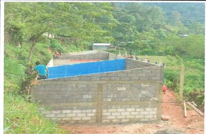
Foto 4: Remodelación de aula tipo portico
