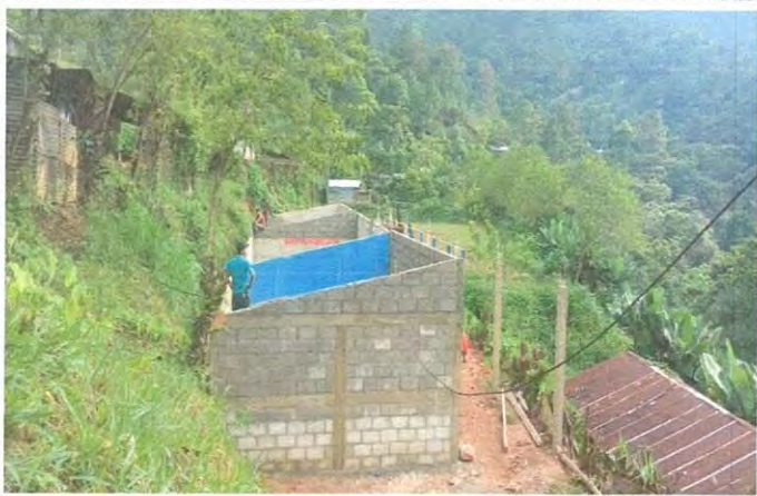
Foto 3: Remodelación de aula tipo portico
