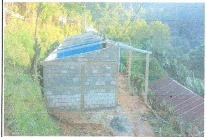
Foto 2: Mejoramiento al módulo de aula (estructura de techo con lámina troquelada calibre 26, piso cerámico, balcones, repación de repello y cernido de paredes)
