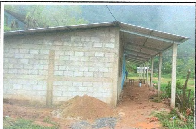
Foto 4: Reparación de losa de patio
