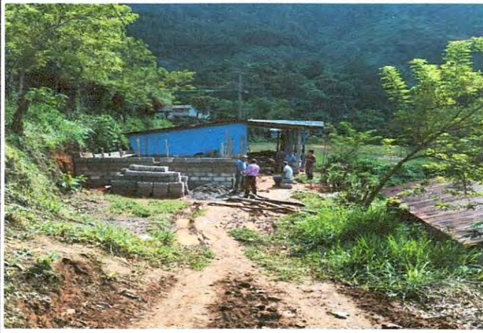
Foto1: Remodelación de aula tipo portico
